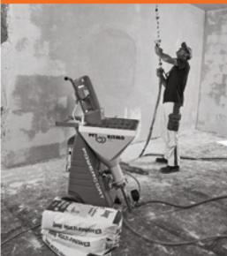
PFT stellt erstmals das revolutionäre System aus Mischpumpe PFT RITMO powercoat und Spachtelmaterial Knauf Multi-Finish M vor. Mit der neuen Möglichkeit, Spachtelmassen maschinell anzumischen und aufzutragen
