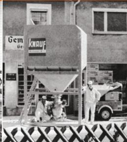
*Beginn einer neuen Ära: die sacklose Baustelle, durch die Erfindung der ersten pneumatischen Werk-trockenmörtel-Förder-anlage der Welt: PFT SILOMAT*
