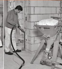
*PFT erfindet die kleinen und leichten Misch-pumpen für Wechsel-stromantrieb: PFT MONOJET und PFT MINIJET. Handlich, einfach, robust, von einem Mann zerlegbar und bedienbar*
