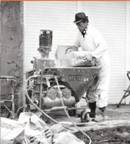
*Erfindung der maschinellen Verarbeitung des ersten einlagigen Maschinenputzes der Welt: KNAUF MP 75*
